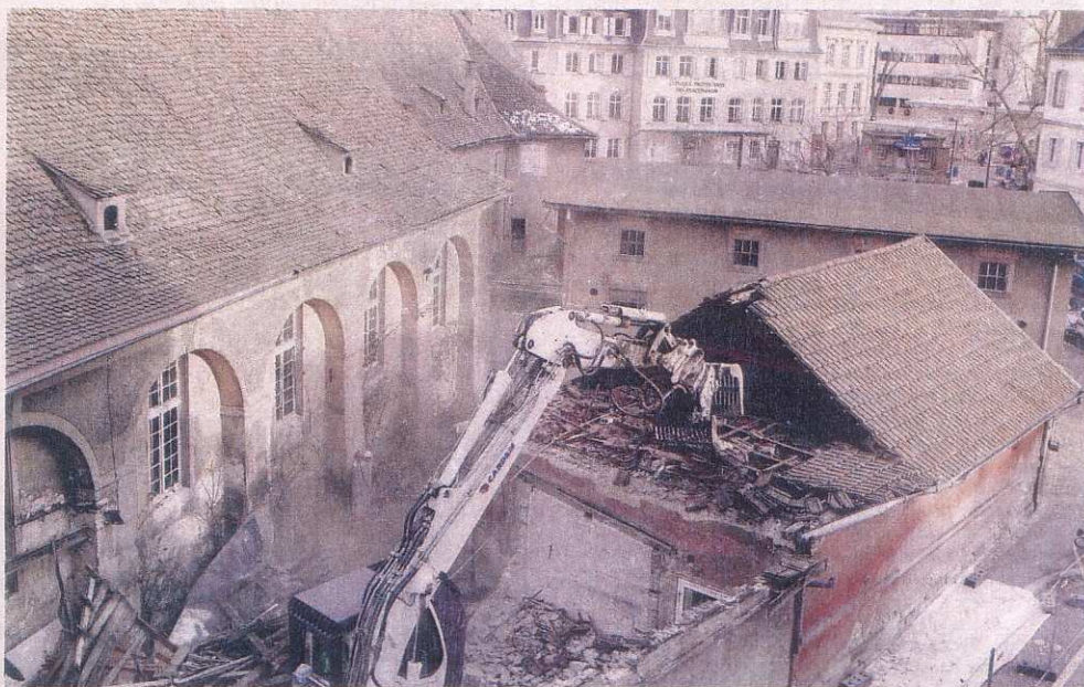
L'ancien laboratoire où se faisait l'insémination des chevaux, au premier plan, et une écurie, à l'arrière, vont être détruites pour accéder à l'ancien mur d'enceinte de la ville. (Photo DNA - Jean-François Badias)
